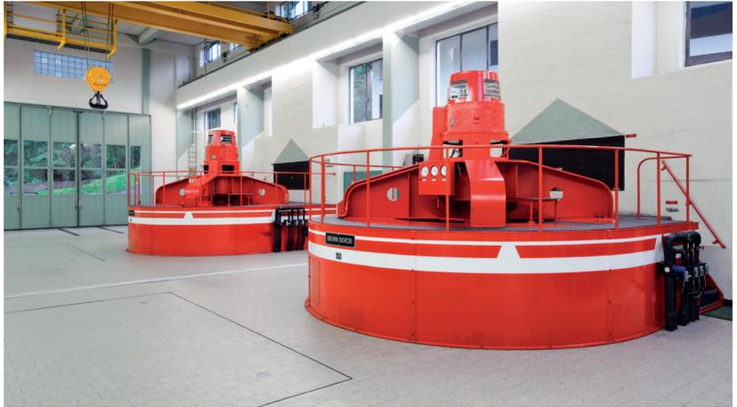
**Das Kraftwerk Wernisberg erzeugt rund ein Drittel des ebs-Stroms und verarbeitet das Wasser der Muota mit drei Francisturbinen.**
